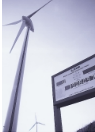
Windenergiepark „Wybelsumer Polder“ der EWE AG, Oldenburg.
